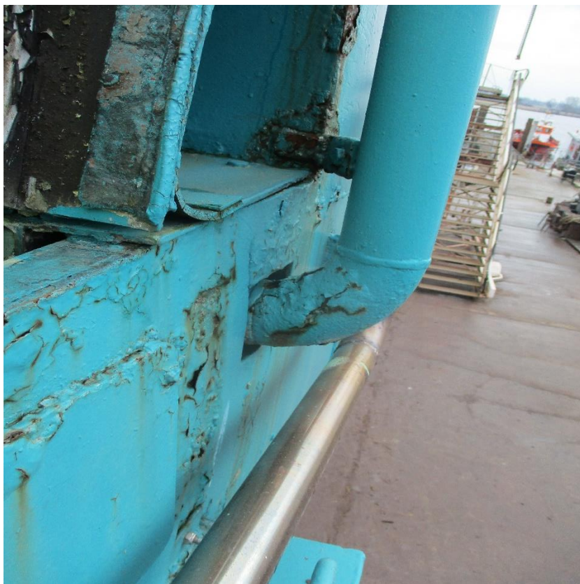
Foto Nr. 15, massive Korrosion an der Außenseite von Steuerhaus und Motorraum (siehe Fotos Nr. 11 bis 16)
