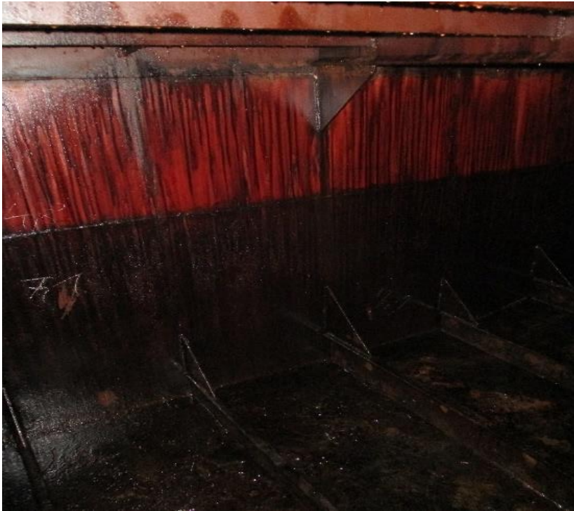
Foto Nr. 115, intakte Leerzelle mittschiffs vorn Stb. Seite, Blick aufs Querschott
