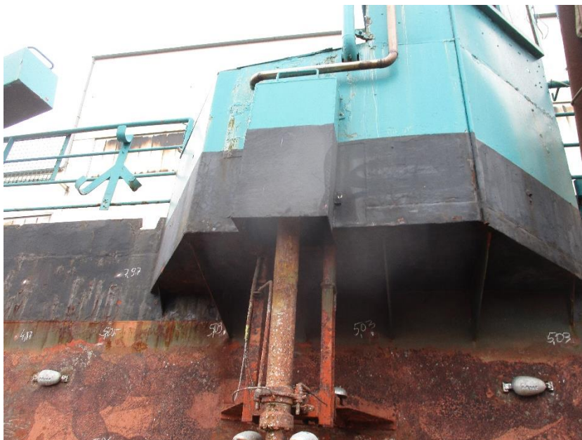
Foto Nr. 15, massive Korrosion an der Außenseite von Steuerhaus und Motorraum
