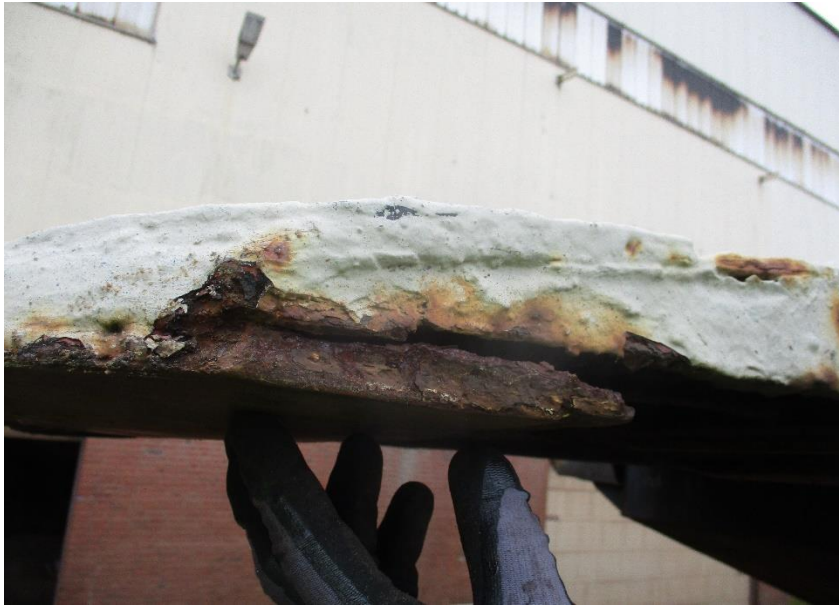
Foto Nr. 25, massive Korrosion an der Rampenflap
