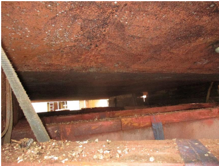
Foto Nr. 08, Blick auf die Heckschräge und den Flachboden mit verschlissenem Farbsystem aber ohne erkennbare signifikante Abrostung.
