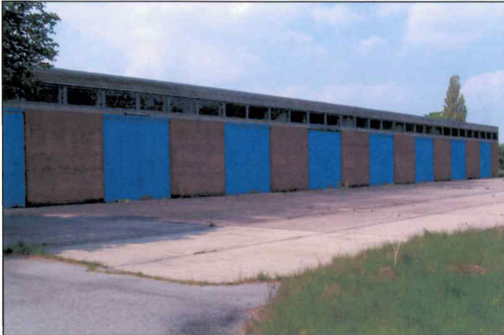
KVF 5: Ausbildungshalle II, Gebäude 33, Ostseite
