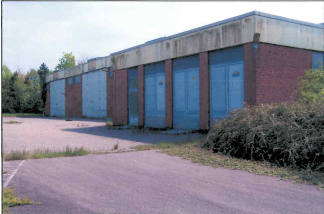
KVF 7: Ausbildungshalle II, Gebäude 33, Nordseite
