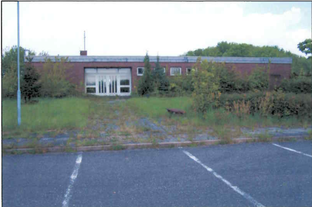
KVF 1: Offiziersheim, Gebäude 20, Südseite
