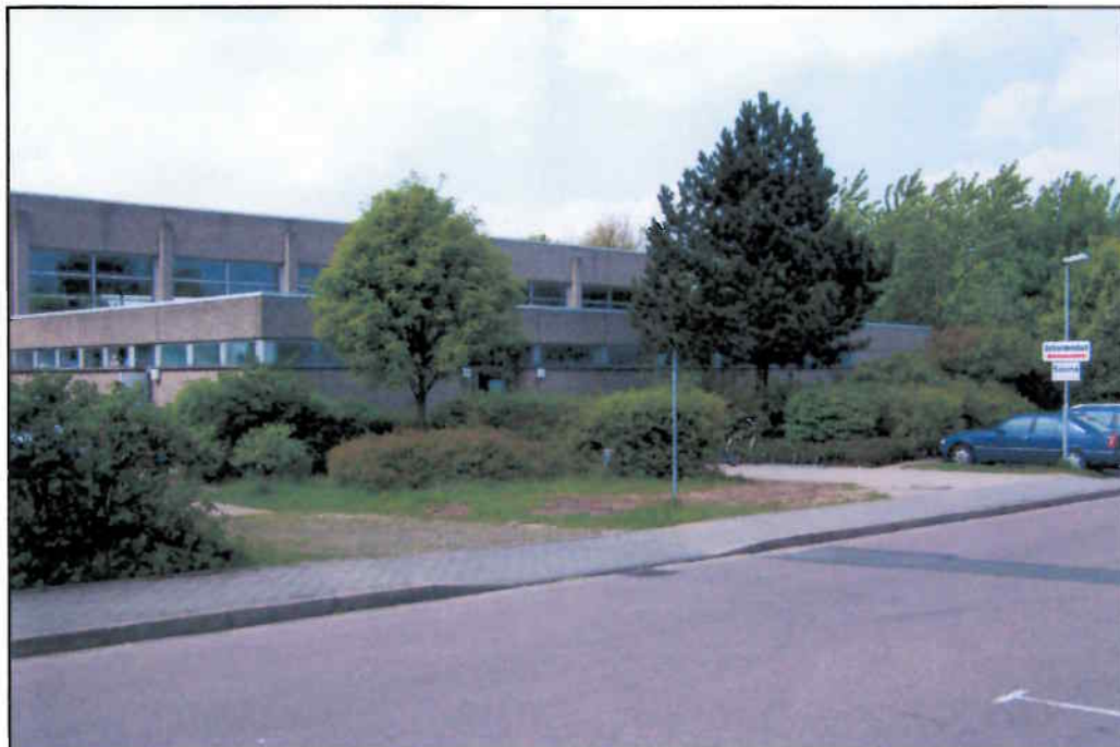
KVF 6: Schwimmhalle/Sauna, Gebäude 32, Ostseite
