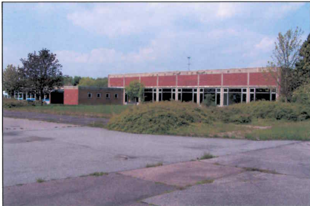
KVF 2: Wirtschaftsgebäude, Gebäude 21, Südseite
