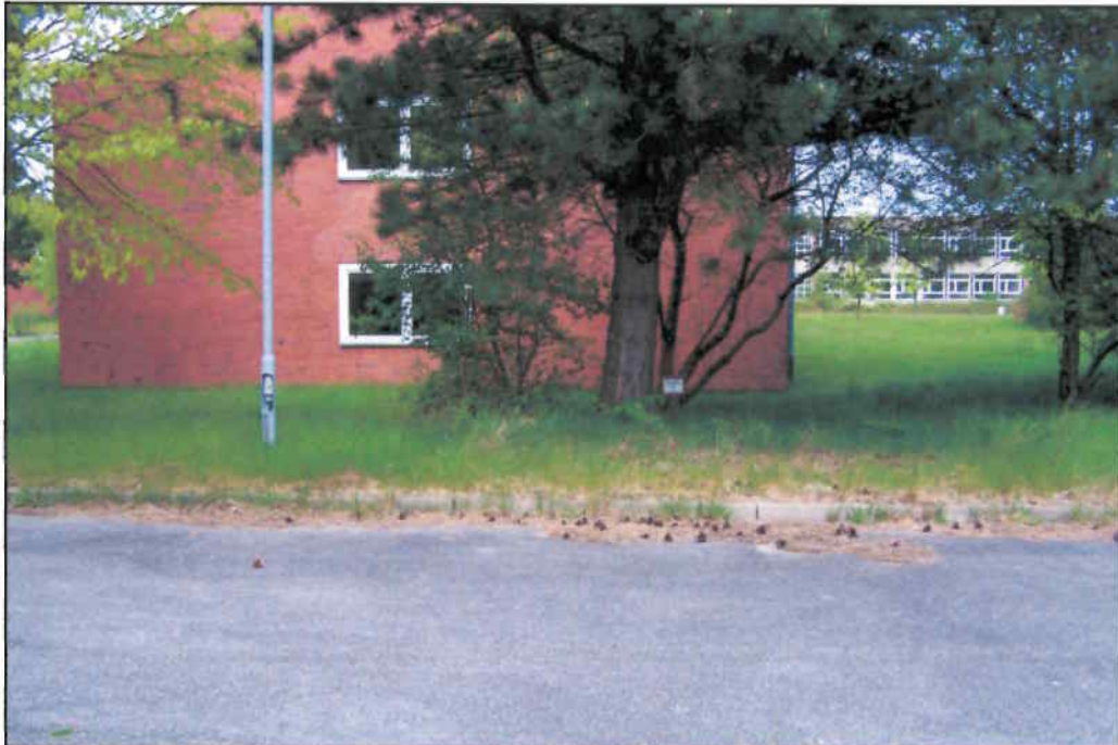
KVF 16: Leichtflüssigkeitsabscheideranlage vom Waschplatz südlich Gebäude 3 Blick nach Norden
