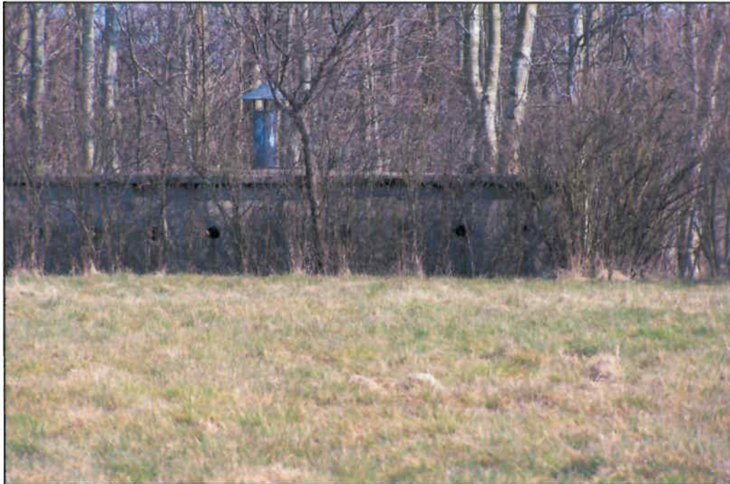
KVF 11: Bunkeranlage zwischen Gebäude 2 und Gebäude 25, Westseite
