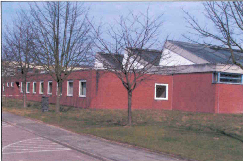
KVF 4: Ausbildungshalle III, Gebäude 25, Westseite
