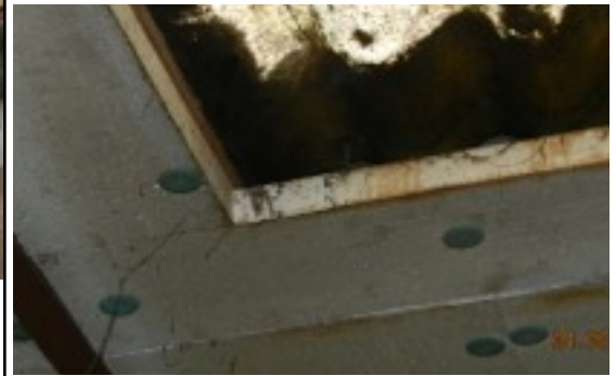
Bootsbauerei Dacheindeckung Eternit- u. Lichtplatten mit Styropor gedämmt.
