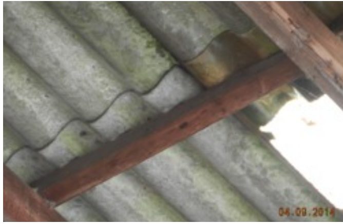
Wasserhalle Dacheindeckung Eternit
