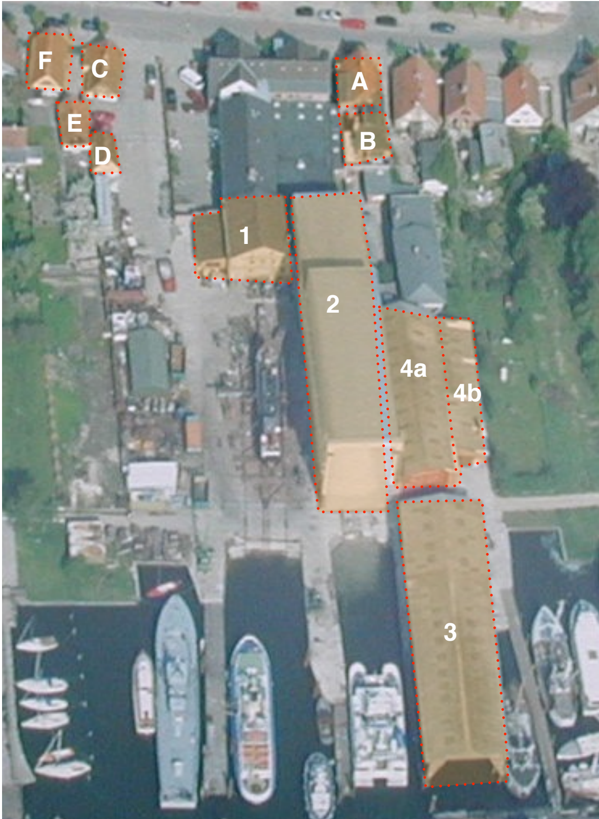
Foto 1: Luftbild des Werftgeländes. Farblich gekennzeichnet der von Rück- bzw. Umbau betroffene Gebäudebestand mit Bezeichnung (A-F; 1-4b) (Quelle: Luftbild, bereitgestellt von Manfred Eberhardt, Aufnahme datum unbekannt)
