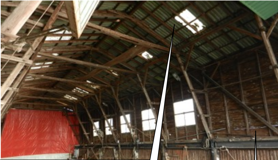
Wasserhalle Dacheindeckung Eternit
